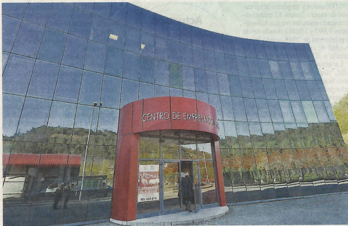
Instalaciones del centro de empresas de Sodeco en El Entrego.
